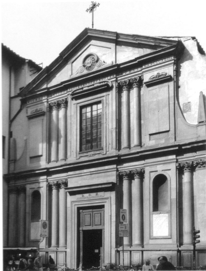
13. Florenz, San Giovannino, Fassade (Foto M. Raspe)
